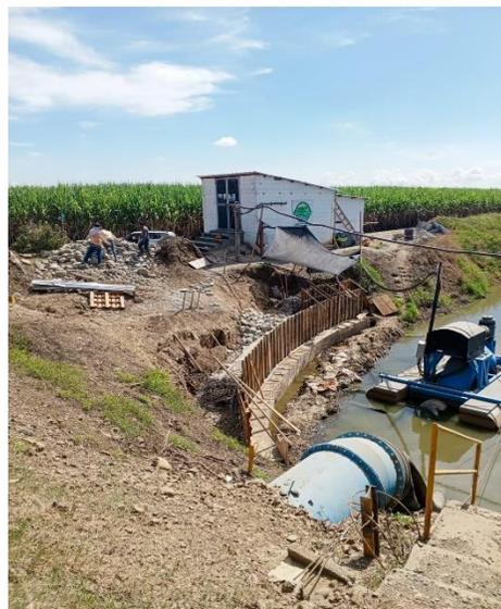
Adicionalmente se efectuaron labores de taponamiento y compactado con máquina excavadora del tramo del dique en su margen derecha entre la Estación y el predio Egipto, sector que presentaba filtraciones por la corona y cara seca.
